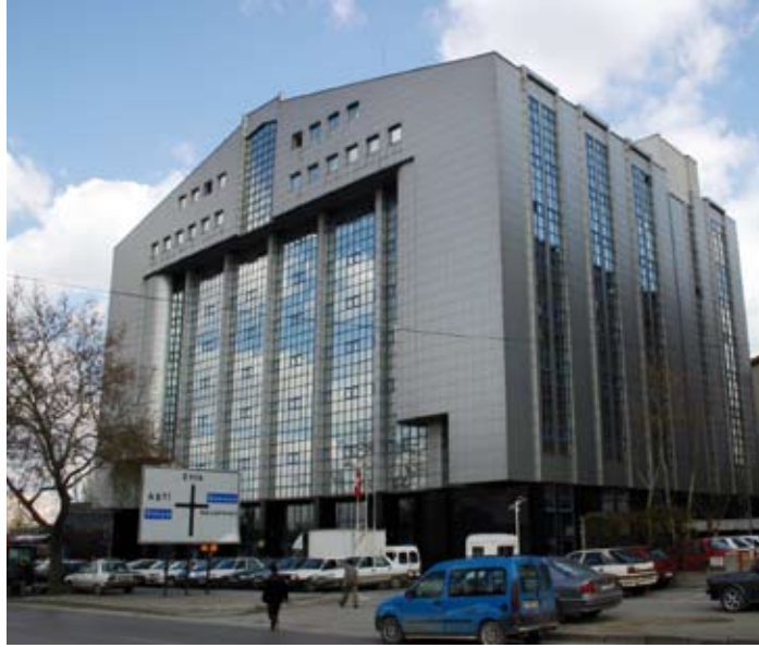
Bilgi İşlem Merkezi Binası
